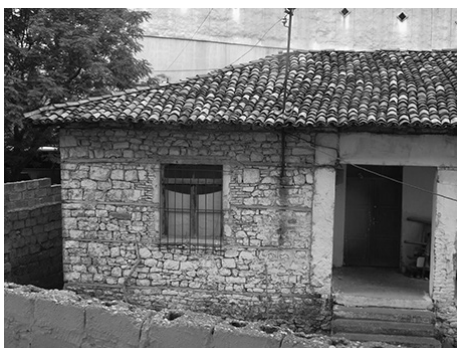
8. kép Ismétlődő deszkarétegek teherhordó kőfalban (hatil szerkezet). A sarkokon csapolással összeerősített deszkák jelentősen lecsökkentik az épületsarkok kidőlésének veszélyét és Ezenkívül ellenállóná teszik az épületet a rengéshullámok által kifejtett vízszintes terheléssel szemben (Dogangün et al. 2006): Elbasan, Albánia.
