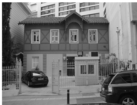
10. kép Favázás épület Athénban. Függőleges oszlopok és vízszintes tartók szerkezetét X-alakú keresztkötések stabilizálják. A faanyag köze téglával vagy vályoggal van kitöltve. Fotó Kázmér M. #1399
