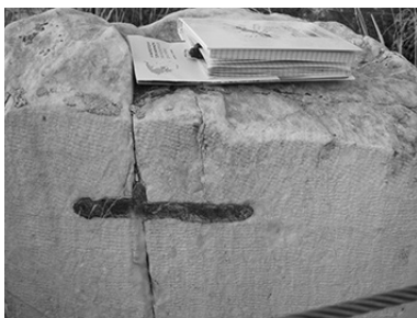
14. kép Ó lomba ágyazott vaskapcsok kötik össze a szomszédos kötőmböket. Erechtheion, Athén, Görögország, Kr.e. 5. század.
