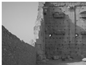
15. kép A szomszédos kötőmböket ólomba ágyazott vaskapcsokkal kötötték össze. Későbbi századokban az ólmot szisztematikusan „újrahasznosították”: a tömbök sarkán a bevésés ennek tanújele. Baál-szentély, Palmüra, Szíria, Kr.u. 1. század.
