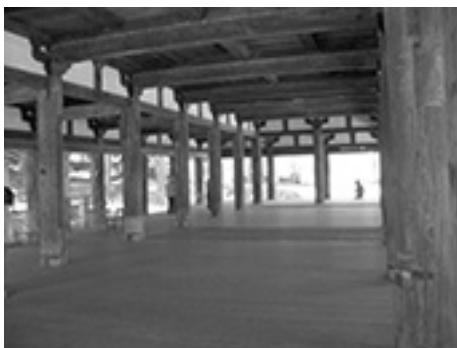
6. kép Vastag függőleges oszlopok és vízszintes tartók alkotnak stabil, háromdimenziós faszerkezetet, amely a nehéz cseréptetőt tartja ebben a buddhista szentélyben. Wakamacu prefektúra, Japán.
